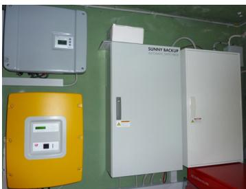
Die von der Fa. Lupo-Energetechnik in Fronreute verbaute Photovoltaik-Anlage (PV-Anlage) ermöglicht eine **weitreichende Unabhängigkeit von externen Stromversorgern**. Der erzeugte Strom wird entweder sofort verbraucht oder im Batterie-Speichersystem zwischengespeichert und später selbst genutzt. **Überschüssiger Strom wird ins öffentliche Netz eingespeist** und führte in den vergangenen Jahren zu einem (monatlichen) **Überschuß-/Auszahlungsbetrag**.
